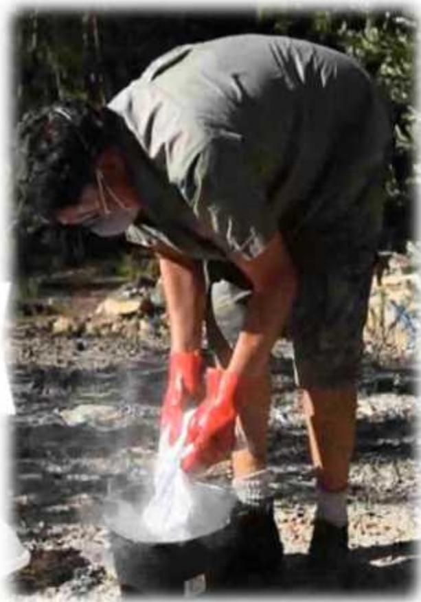
Debe ser minuciosamente mezclado con agua limpia y fría antes de usar, en una proporción del 30% del peso total. Poner la cantidad necesaria de agua, 1.5 - 1.7 litros de agua por cada bolsa de cemento de 5 Kg, en un recipiente largo y después añadir gradualmente el polvo en el agua removiendo en todo momento para obtener una mezcla suave y sin grumos.
