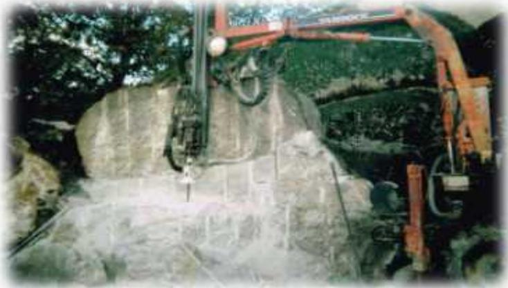
Los agujeros deben ser taladrados para permitir una cara libre para que el CEMENTO EXPANSIVO ROAR pueda empujar. Por ejemplo, taladrando en un ángulo de 45° en una superficie llana, lo empujará hacia arriba, pero taladrando derecho hacia abajo, puede que no permita ninguna salida a la presión.
